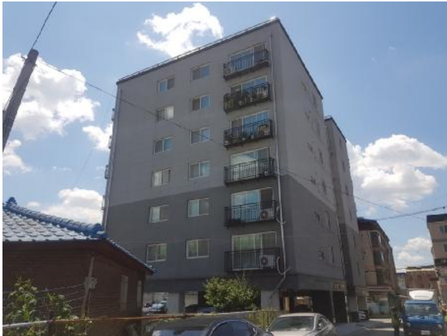
본건 전경(북동측에서 촬영)
